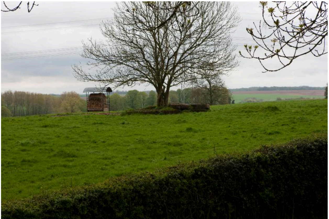
Bunker de tir hexagonal.
