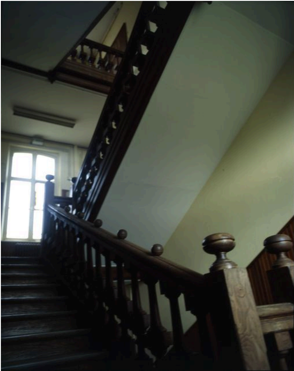
Escalier de distribution intérieur.
