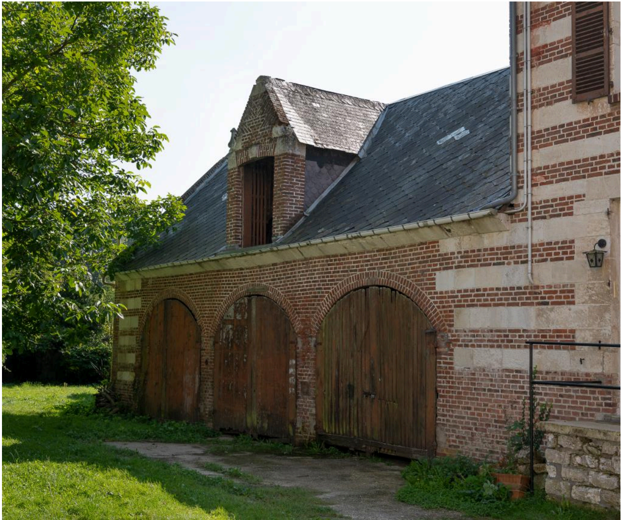
Remise agricole vue depuis l'ouest.
