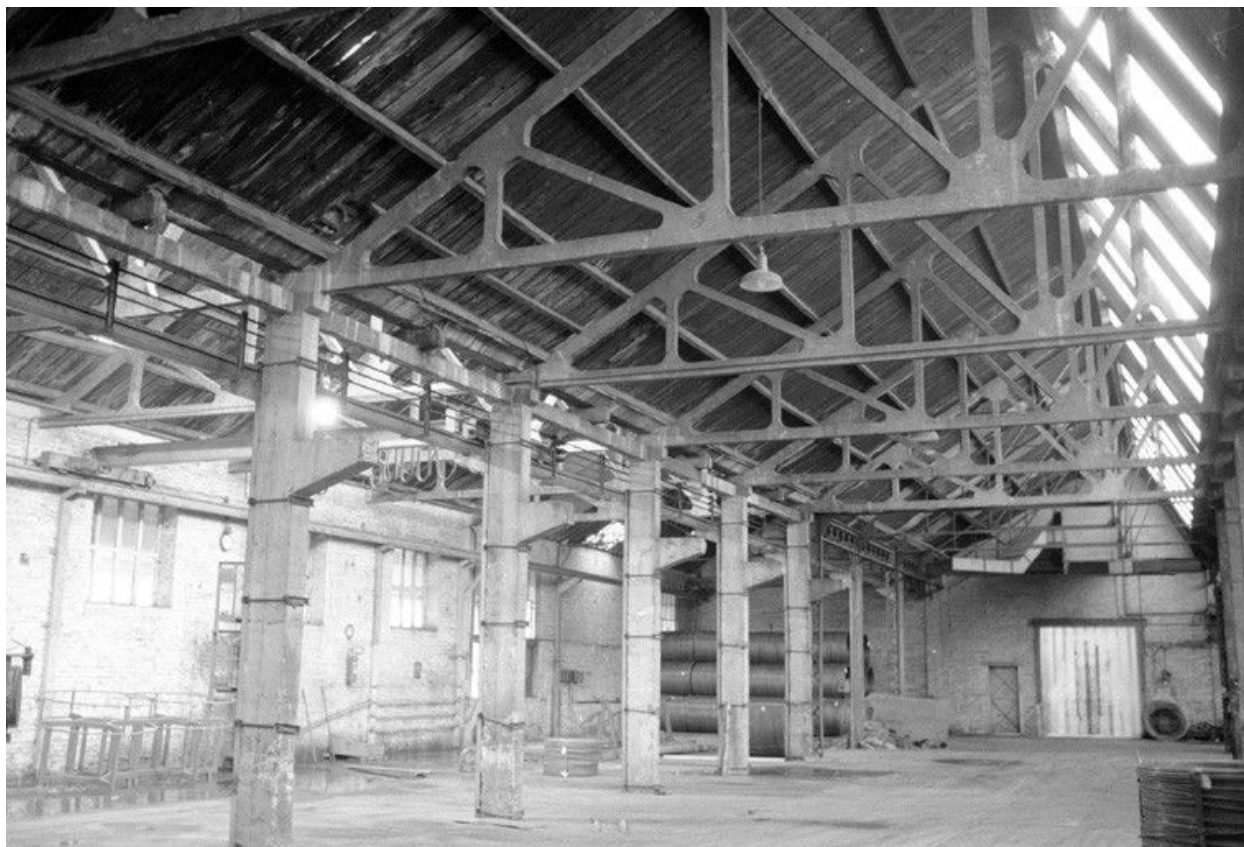
Atelier de fabrication : vue intérieure.
