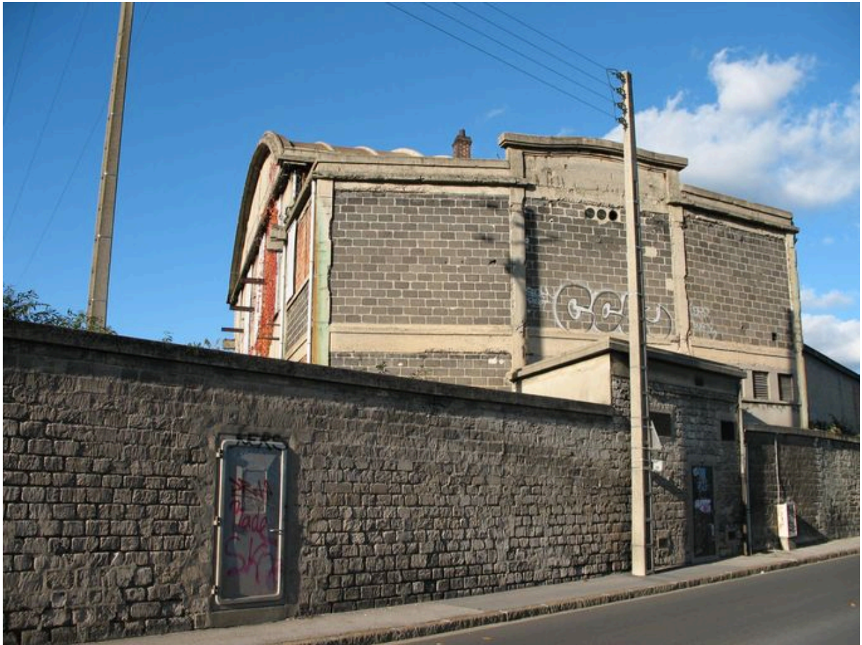
Façade sud-ouest de la tréfilerie.
