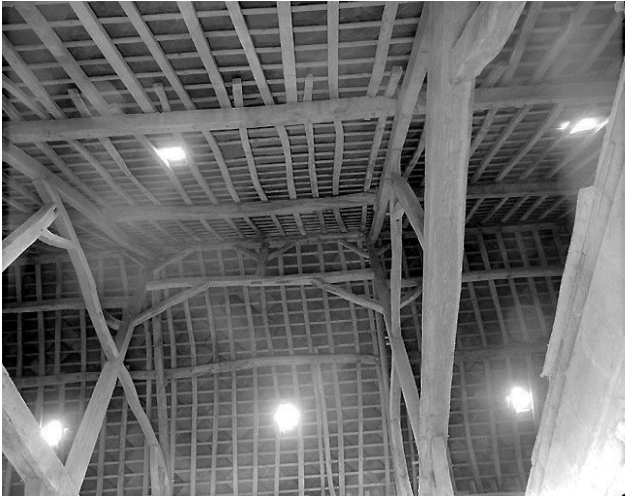
Charpente de la grange.
