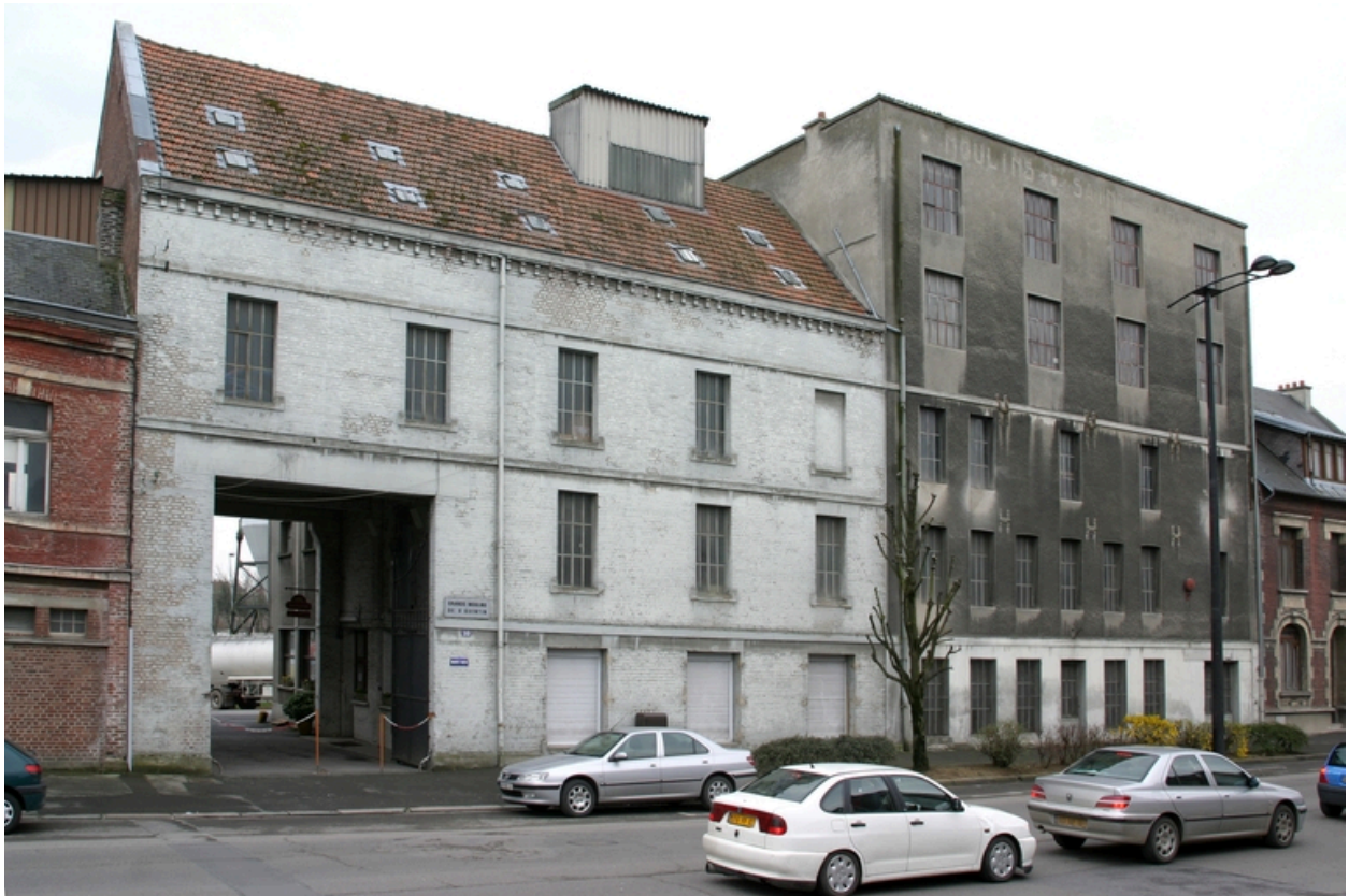
Façades antérieures de l'ancienne minoterie (à gauche) et de l'actuelle (à droite).
