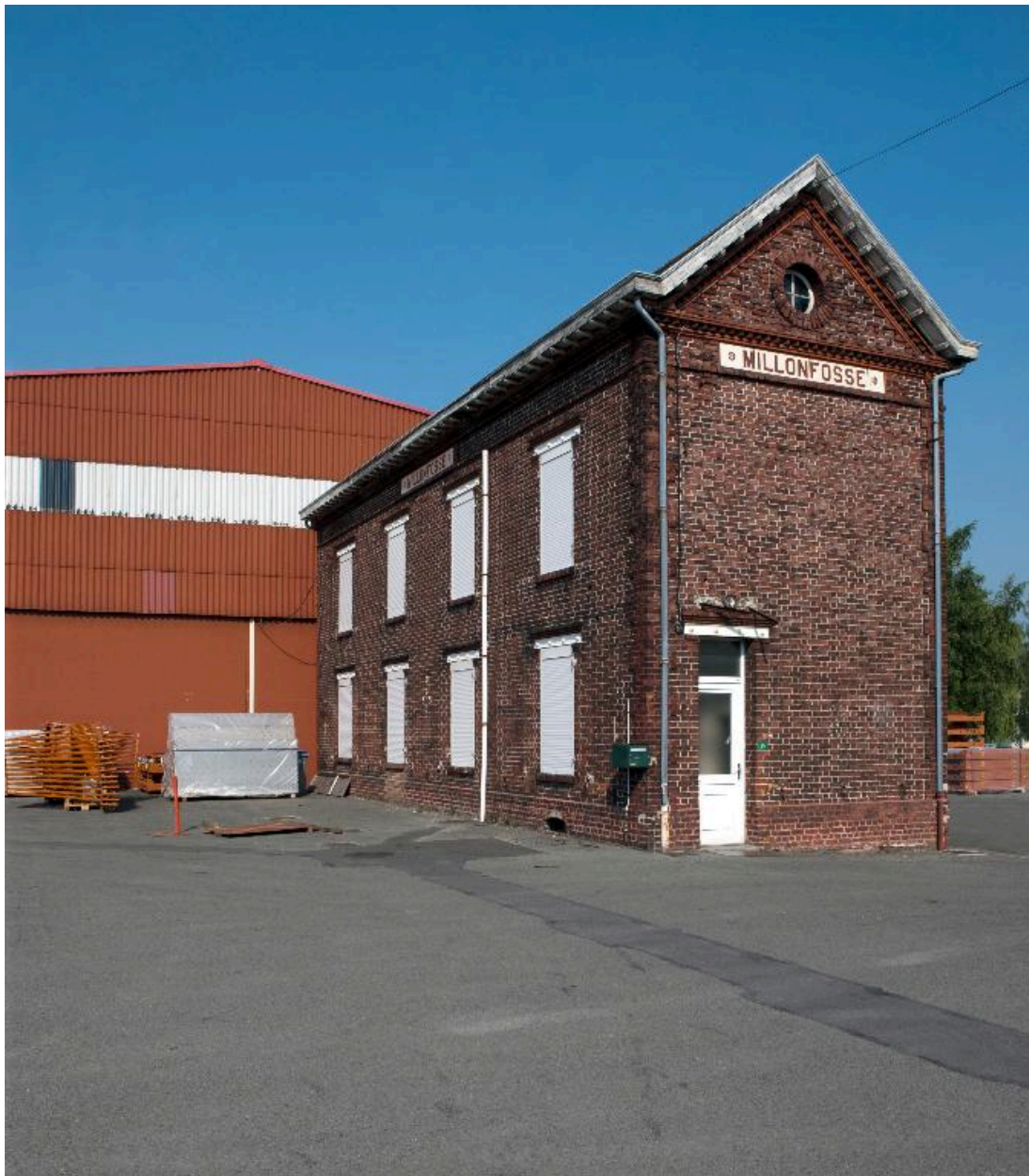
Vue de trois quarts, l'élévation antérieure.
