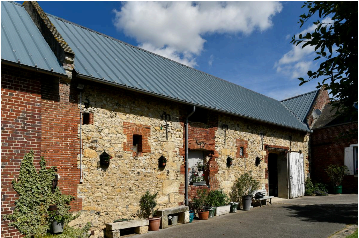
Vue des anciennes écuries depuis le sud-est.
