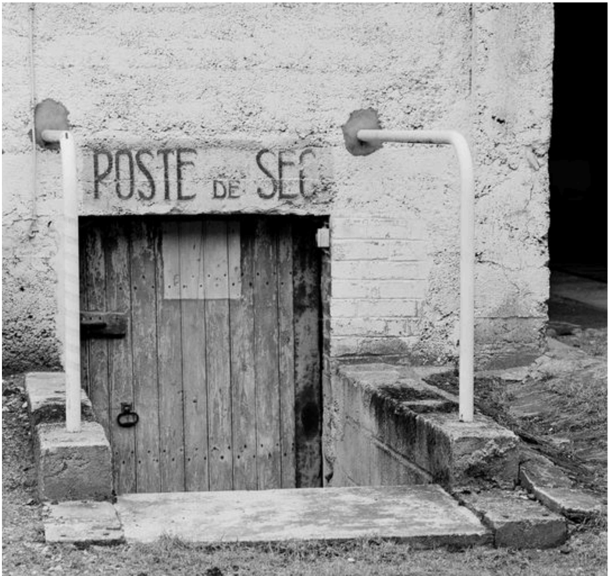
Entrée du poste de secours.
