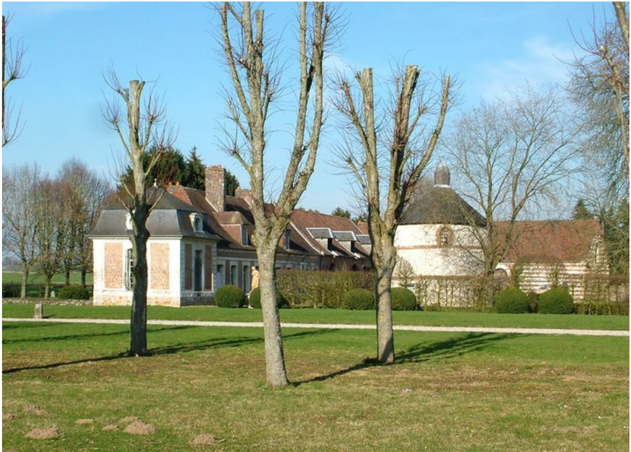
Vue générale des communs depuis la cour.
