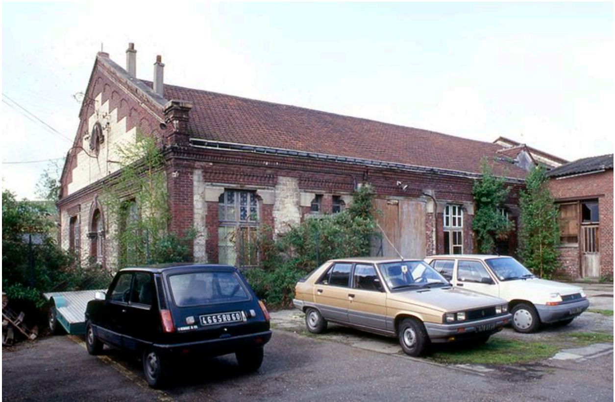
Façade est de l'atelier en 1992.
