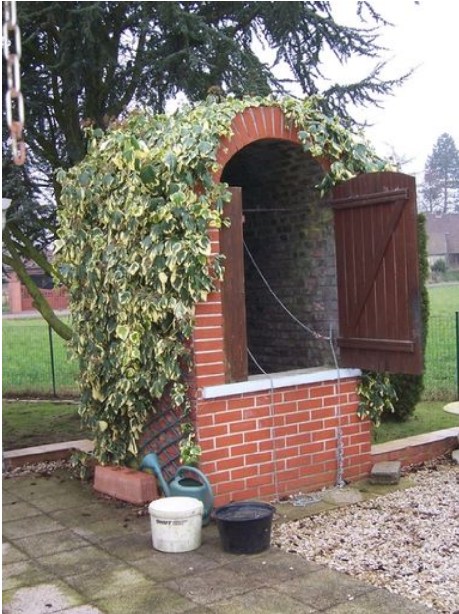
Vue générale du puits E.
