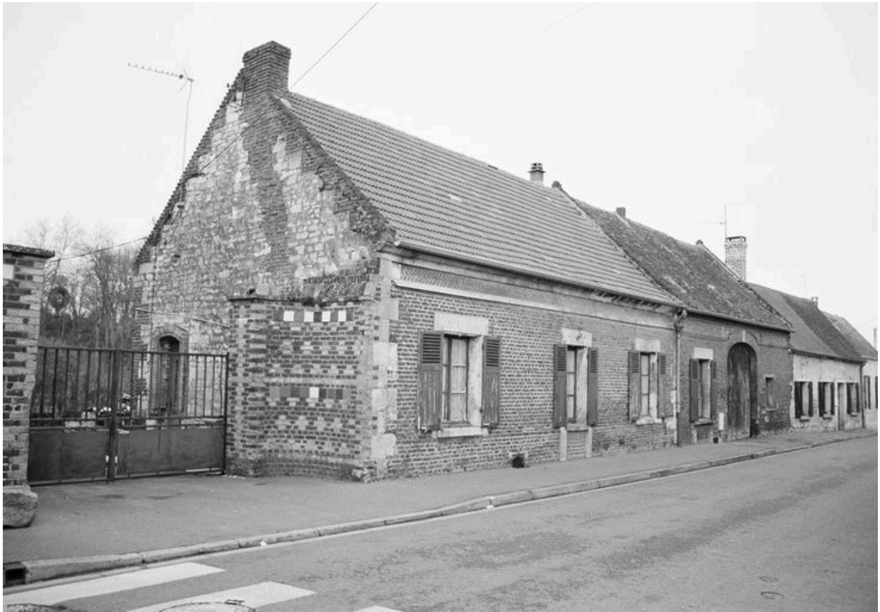
Maison de briquetier : façade sur rue.
