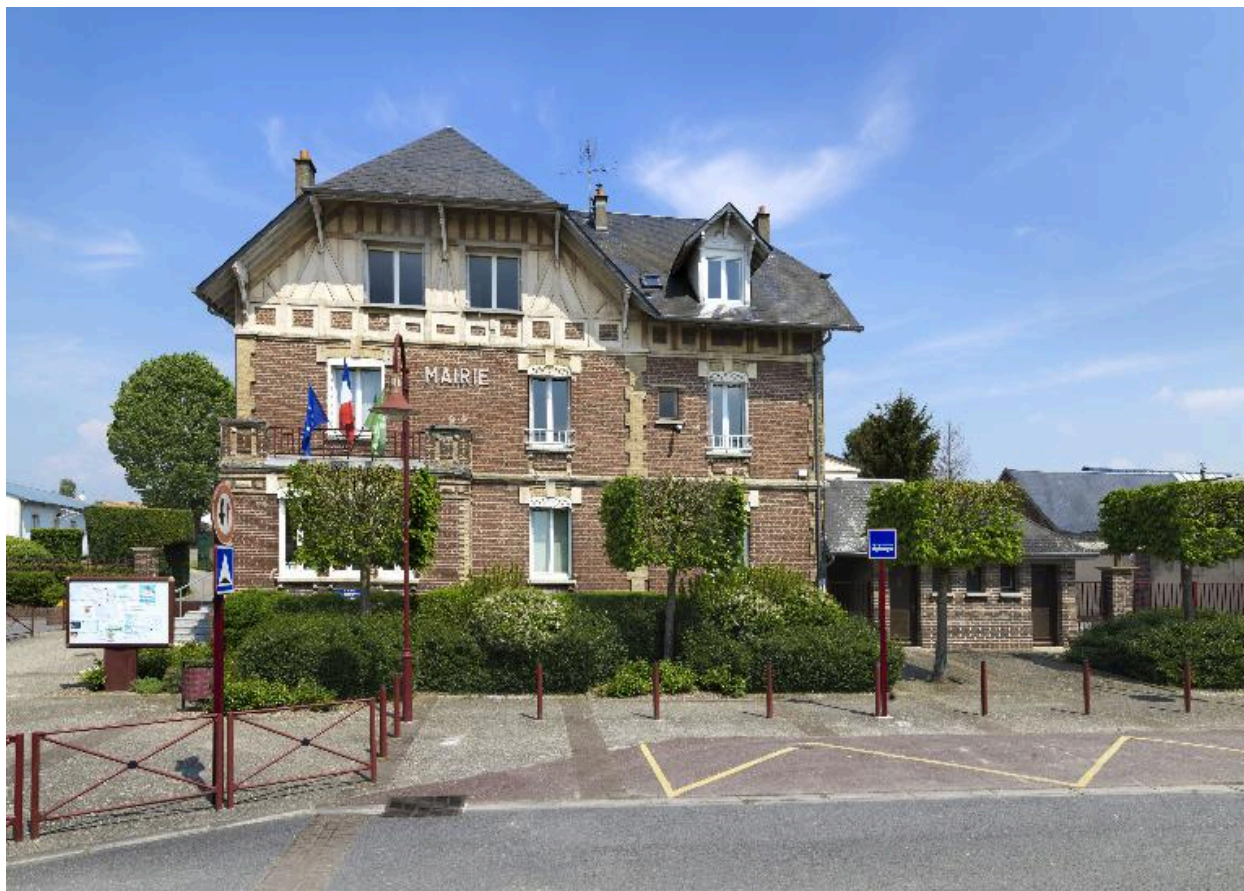
Vue générale, façade sur rue.
