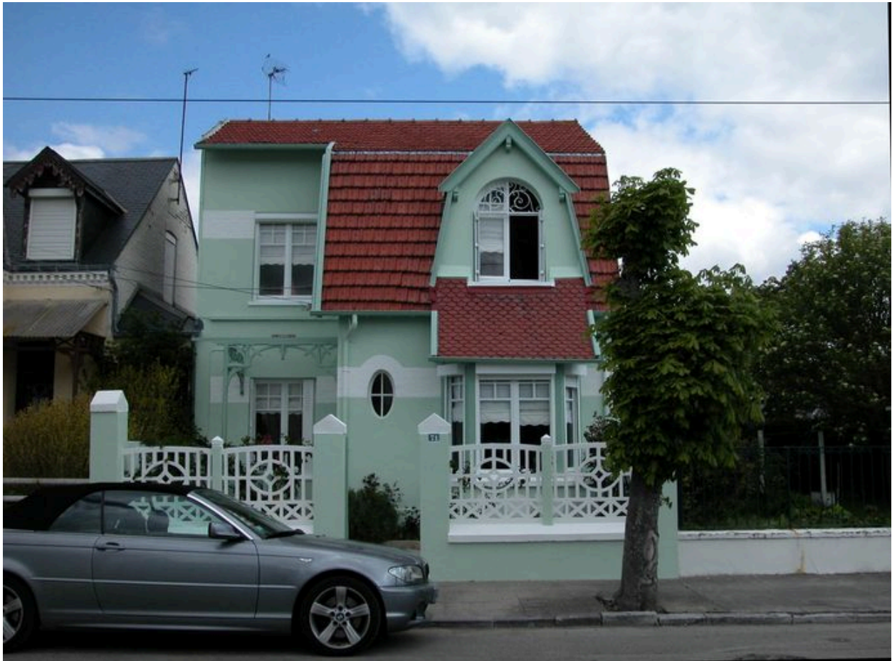
Clôture en ciment d'une maison de l'entre-deux-guerres, 71 avenue Carnot (1988 BB 42).
