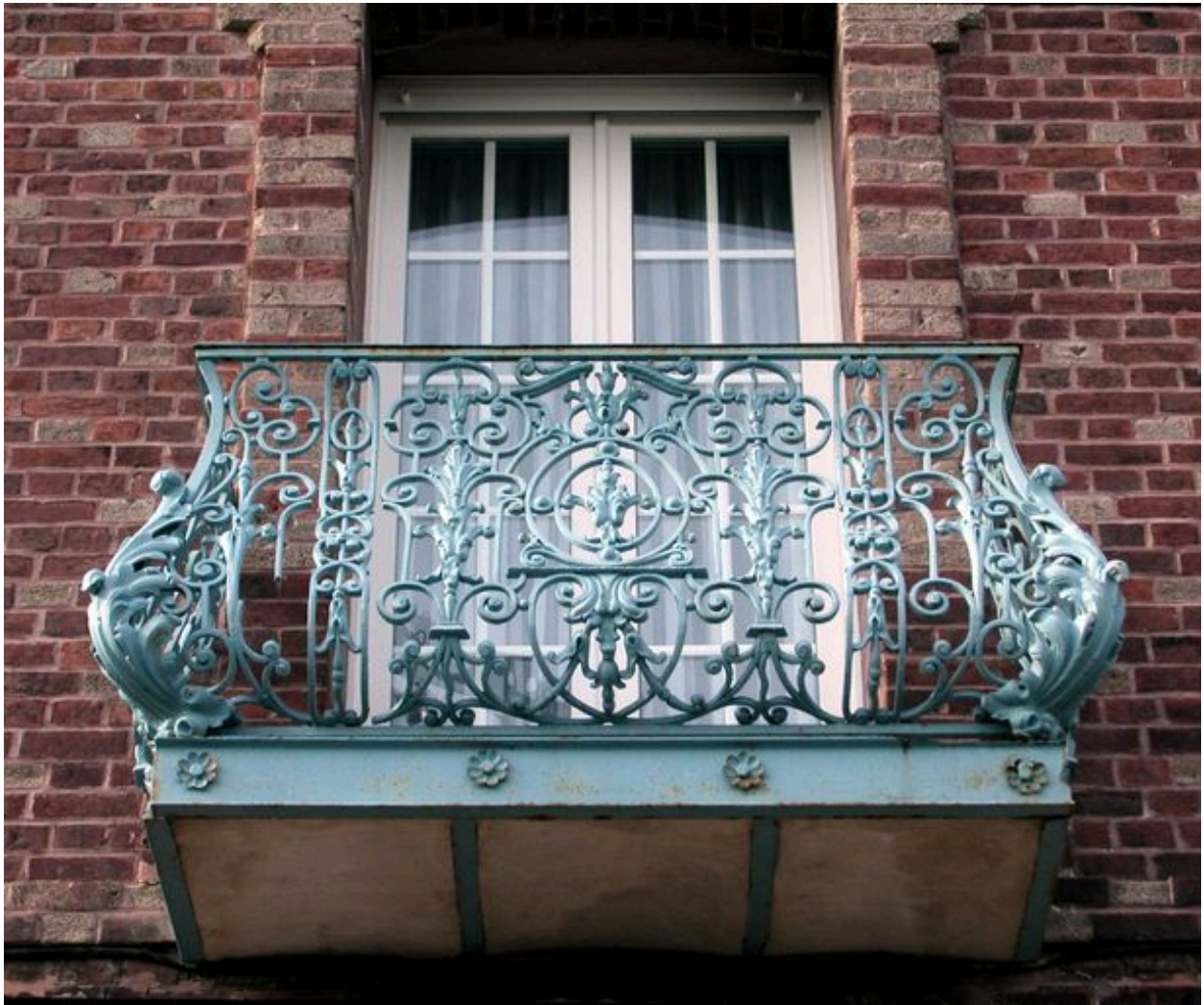
Détail du décor de fonte du garde-corps de balcon de l'habitation sur l'angle, dite Titania.
