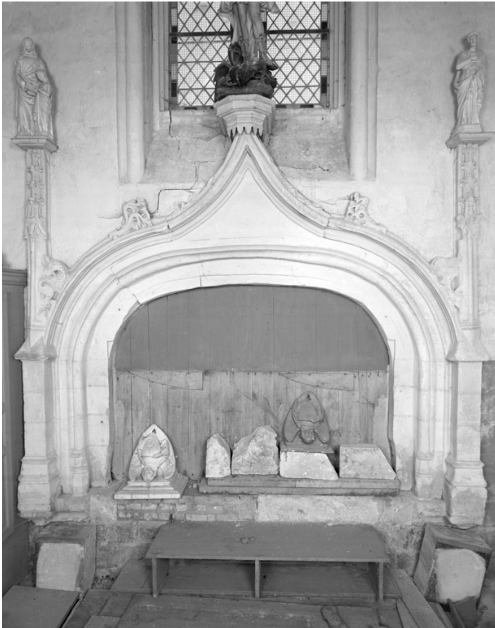
Arc en accolade, dans la chapelle sud.
