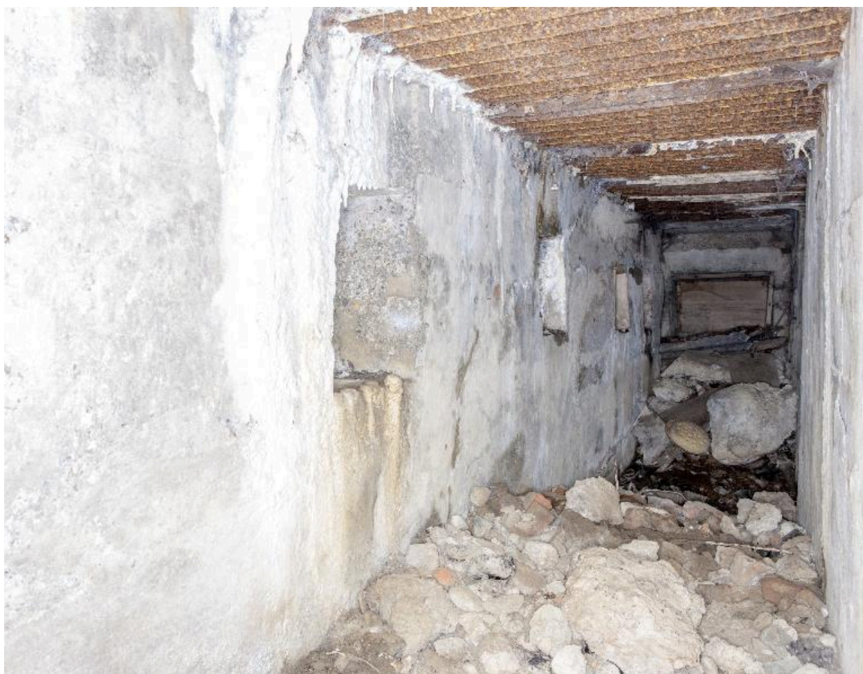
Casemate A, couloir de distribution intérieure, vers le sud-ouest.
