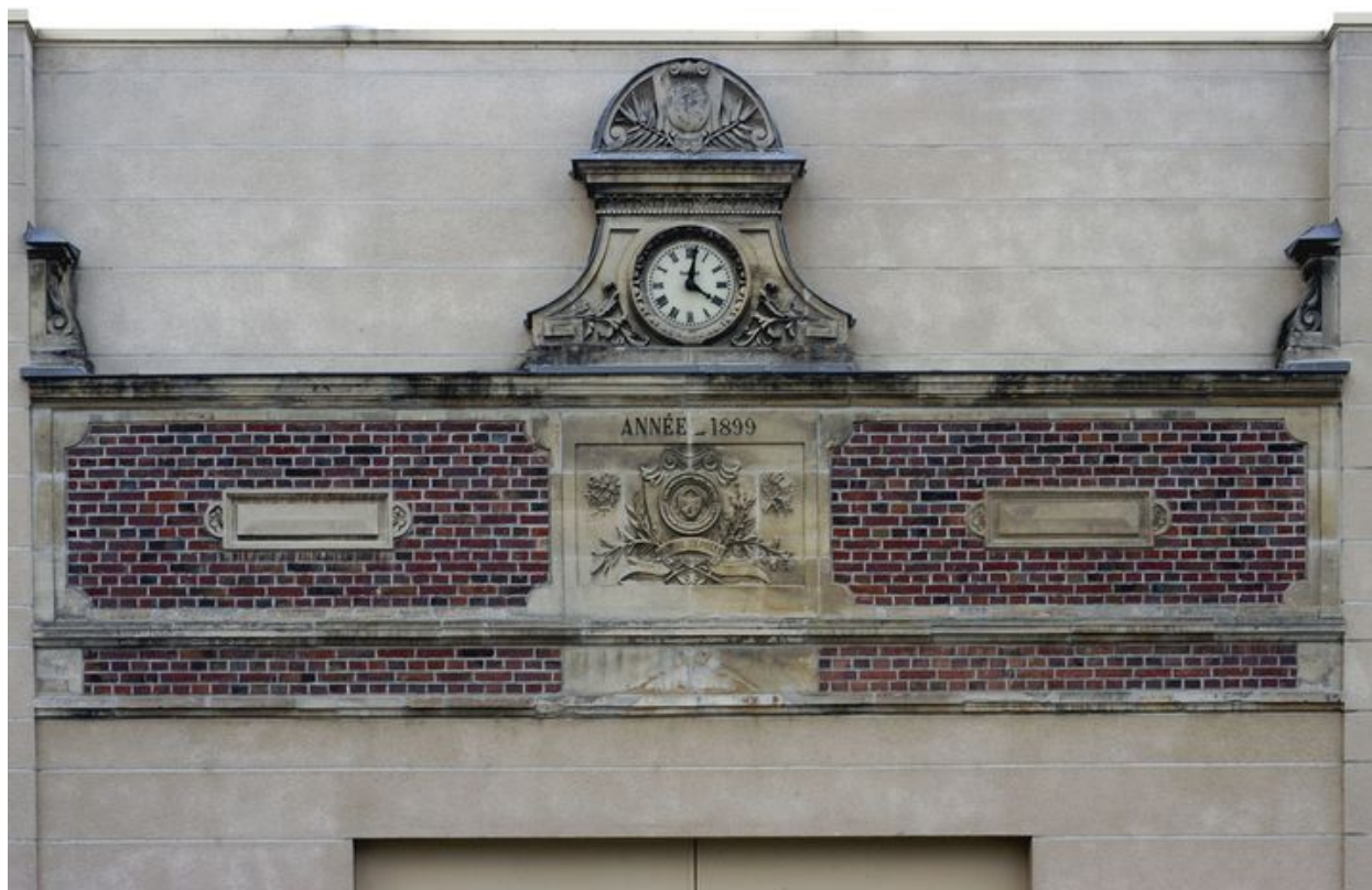
Façade sur rue du magasin industriel, détail du fronton portant la date de 1899.
