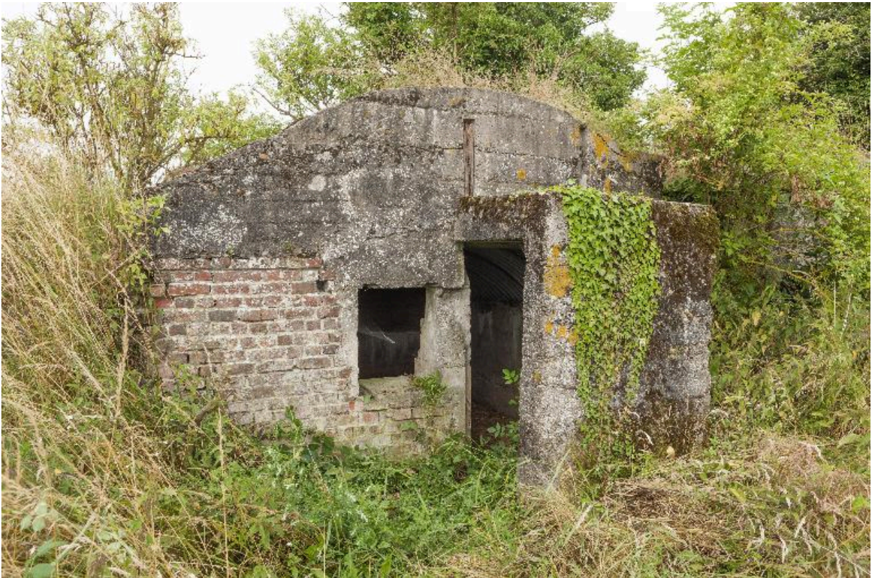
La casemate b et son entrée pare-souffle
