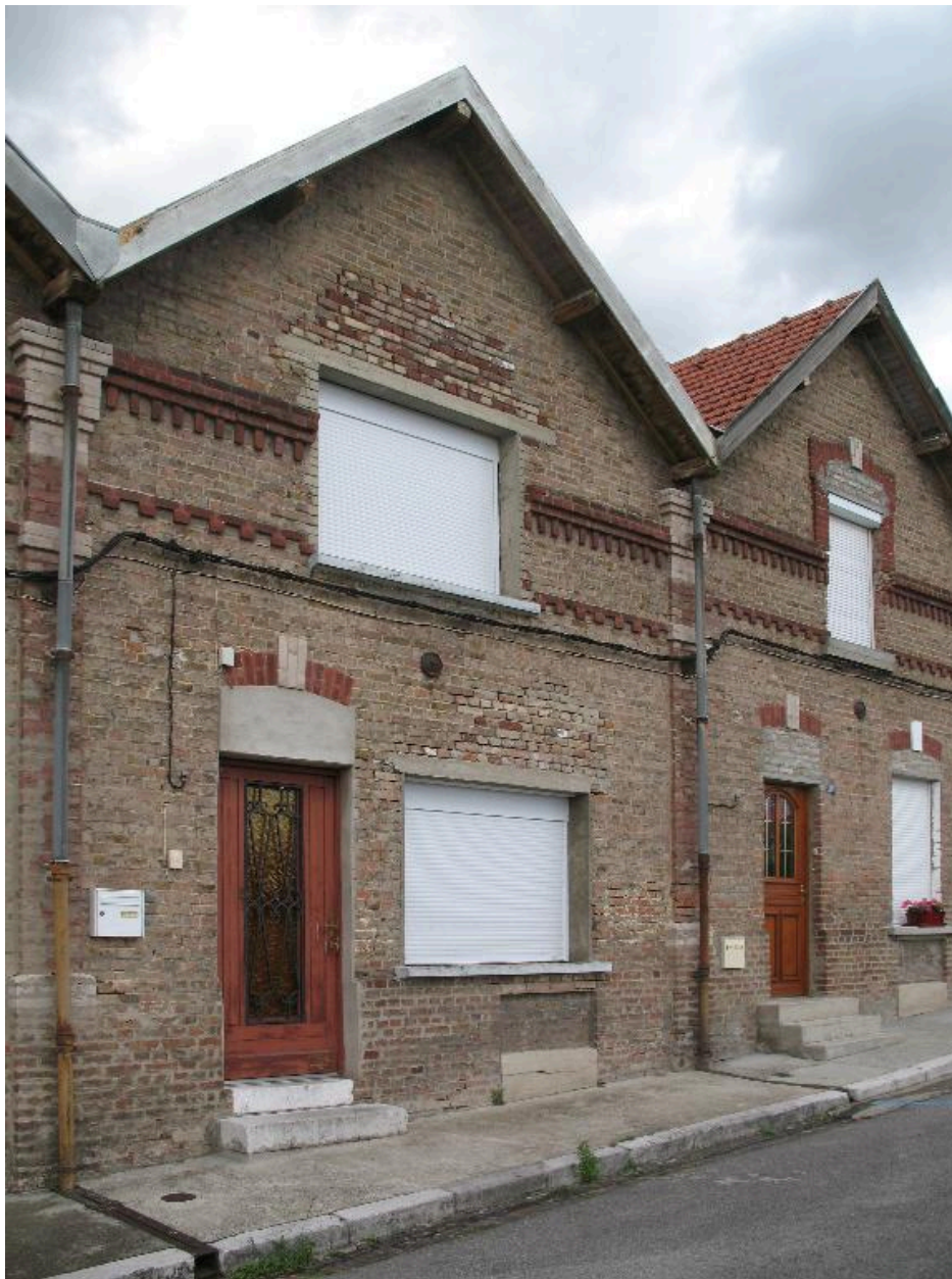
Façade sur rue du logement 285, rue Anthime Gigaut.
