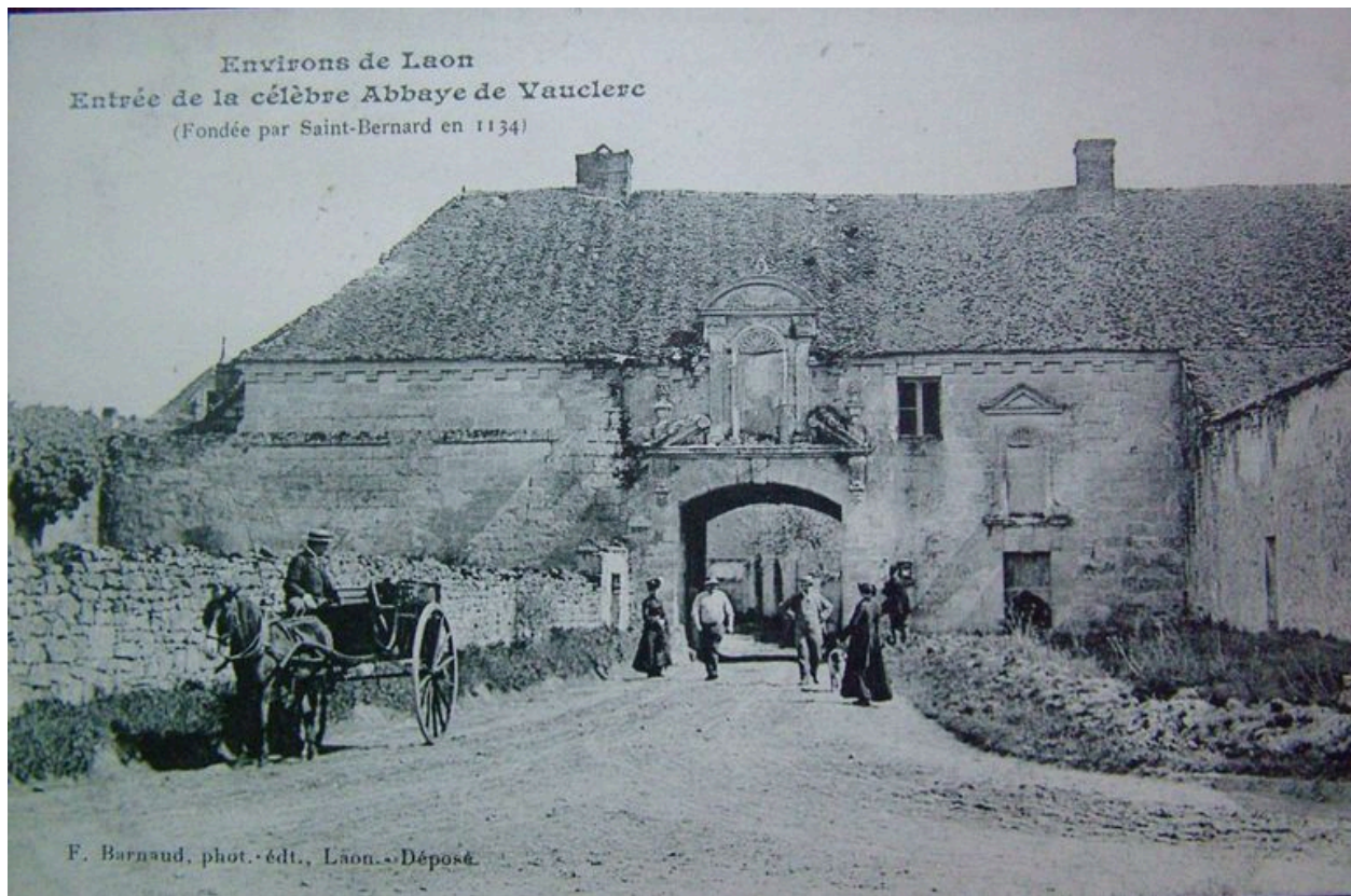
Vue ancienne de l'entrée de l'abbaye (coll. part).
