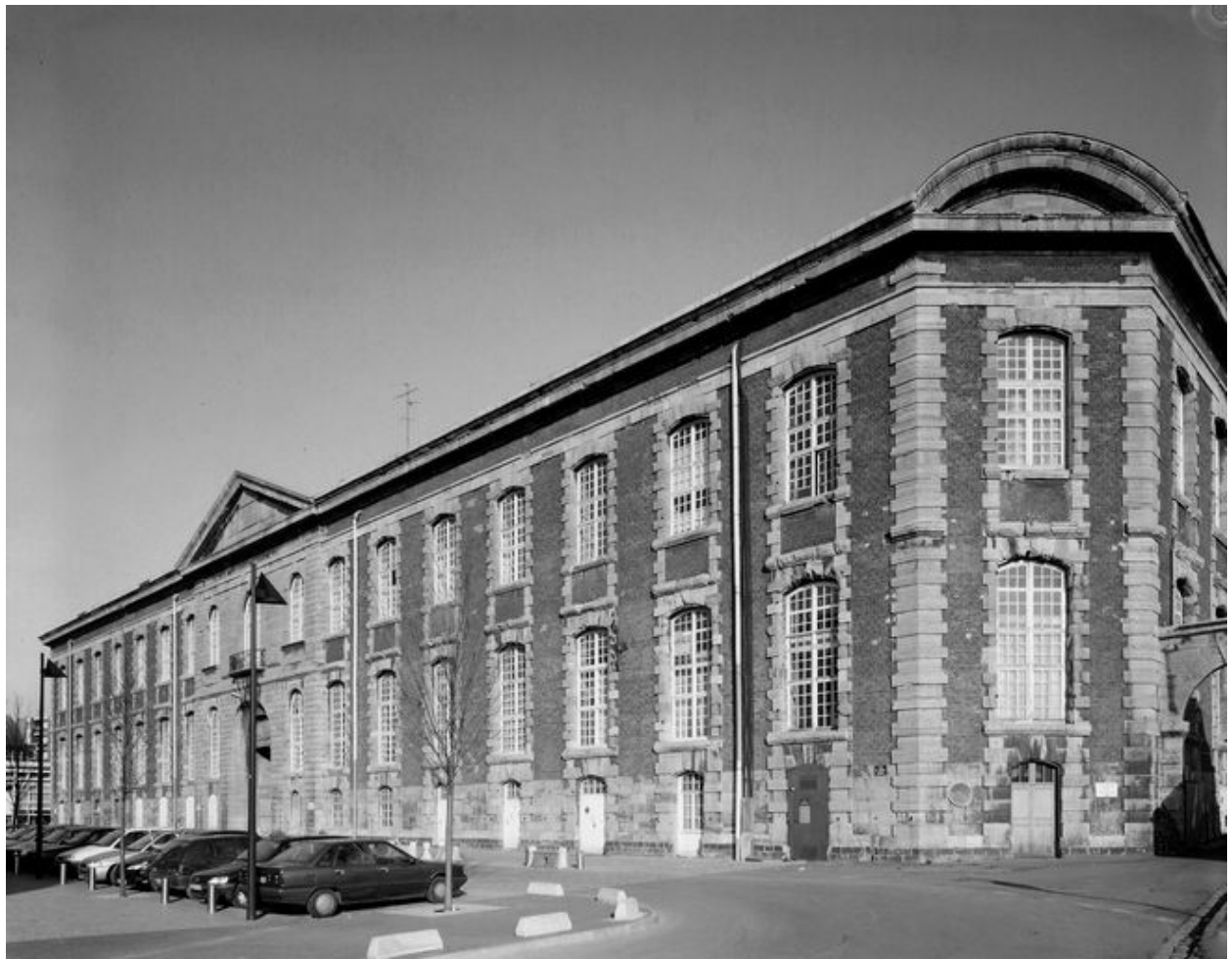
Façade principale donnant sur la place de l'Hôpital-général, vue générale prise de trois-quarts droit.
