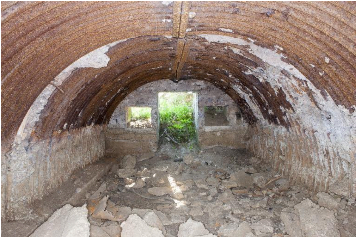
Vue intérieure, vers le sud-ouest
