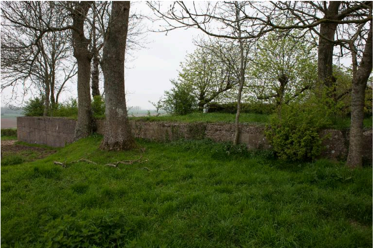
Second abri de stockage en forme de ski. Extrémité nord.
