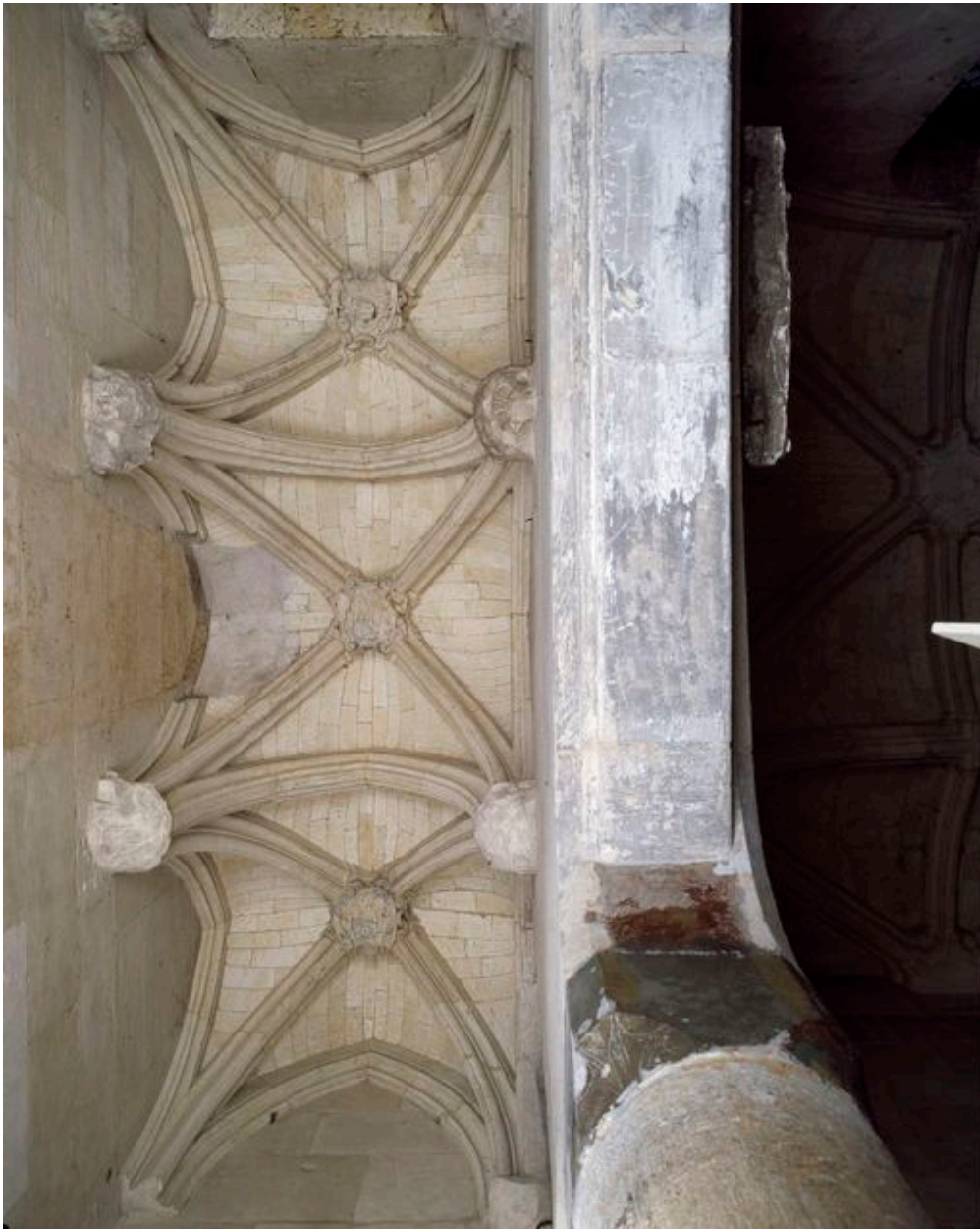
Détail de la voûte de la chapelle Saint-Fursy.
