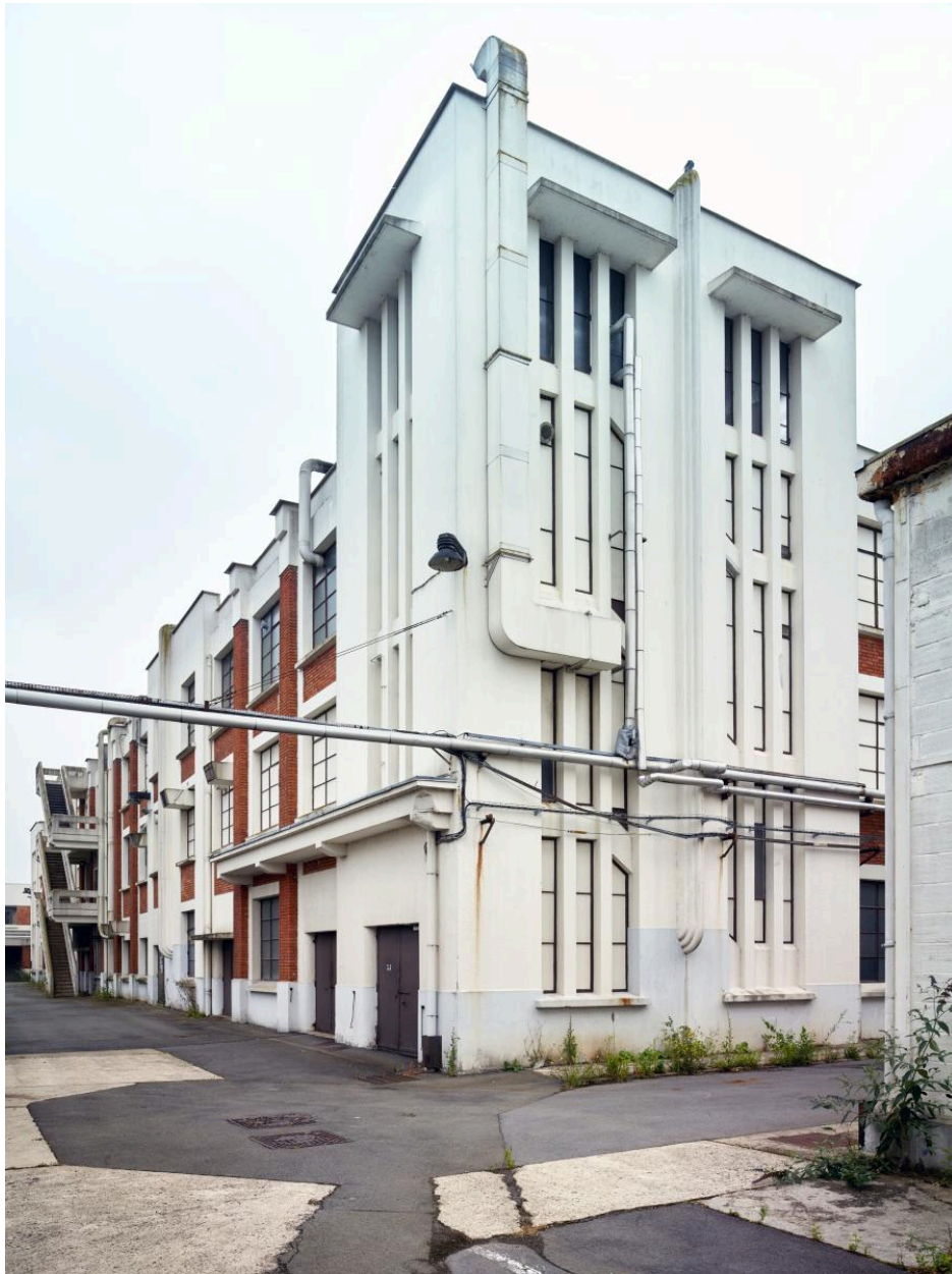
Vue de trois-quart vers le sud-est de l'atelier de fabrication (G). Au premier plan, la tour d'escalier demi-hors-oeuvre.
