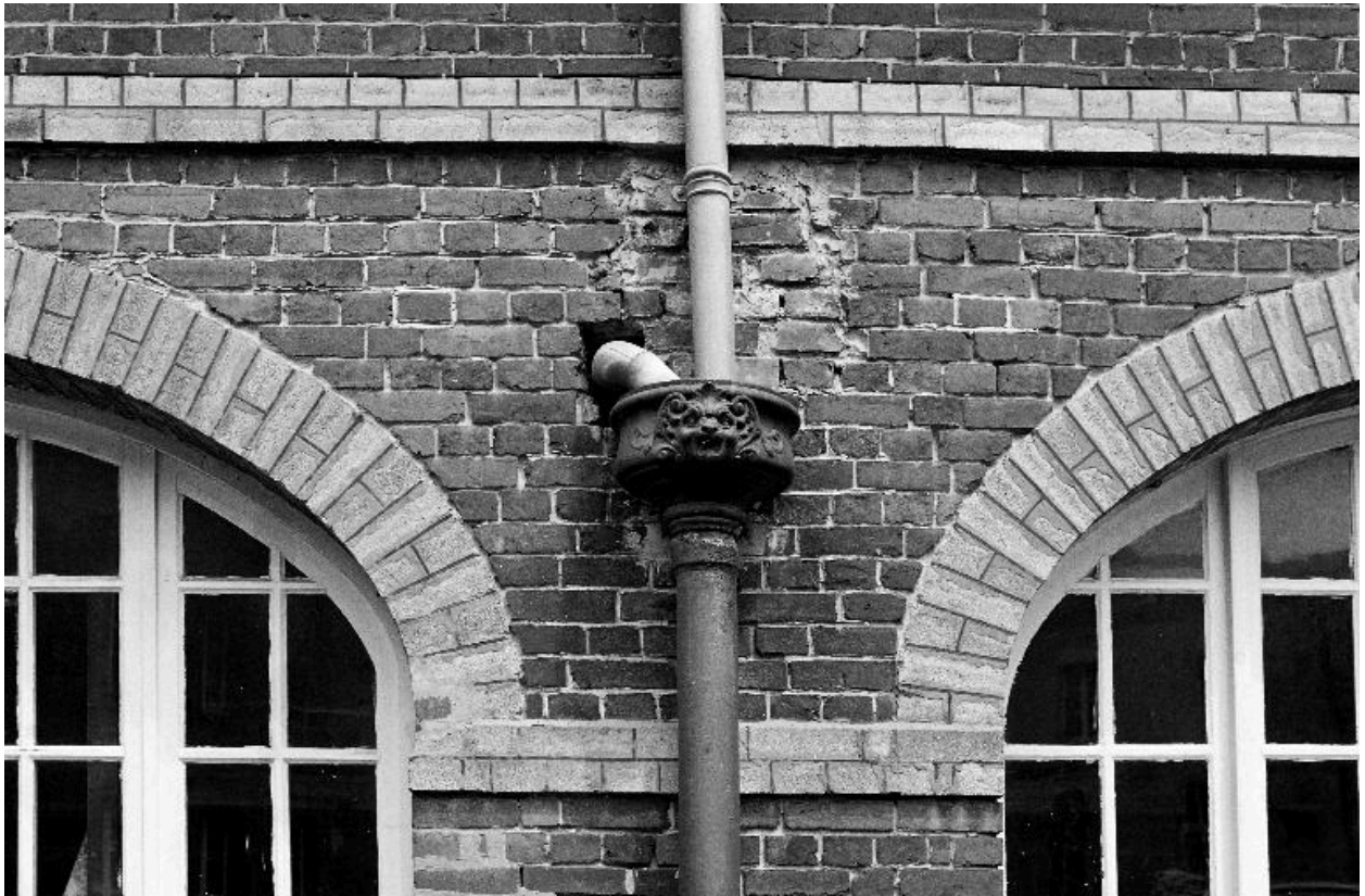
Atelier de fabrication, sud-est, détail, en 1990.
