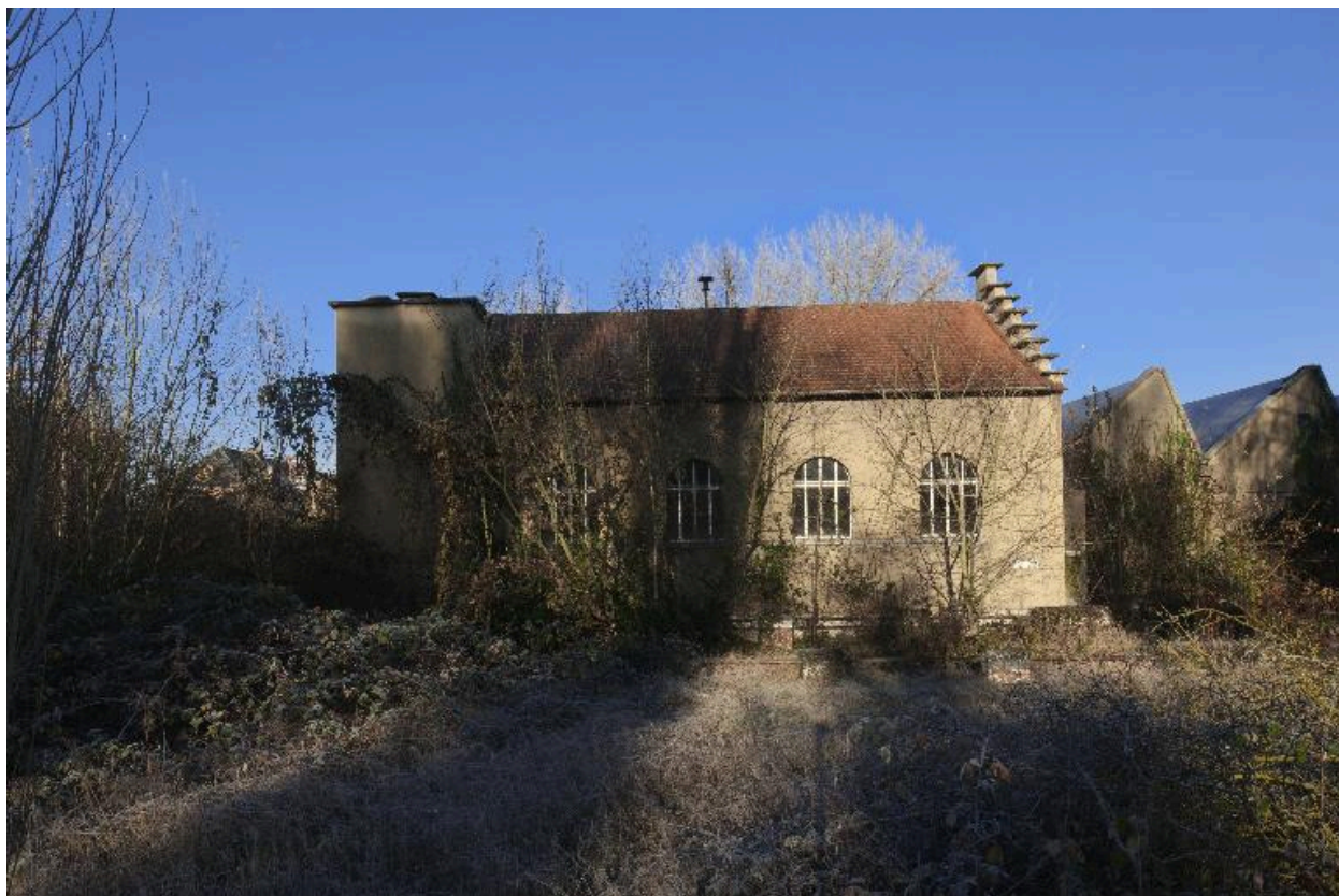
Façade latérale sud du transformateur électrique.
