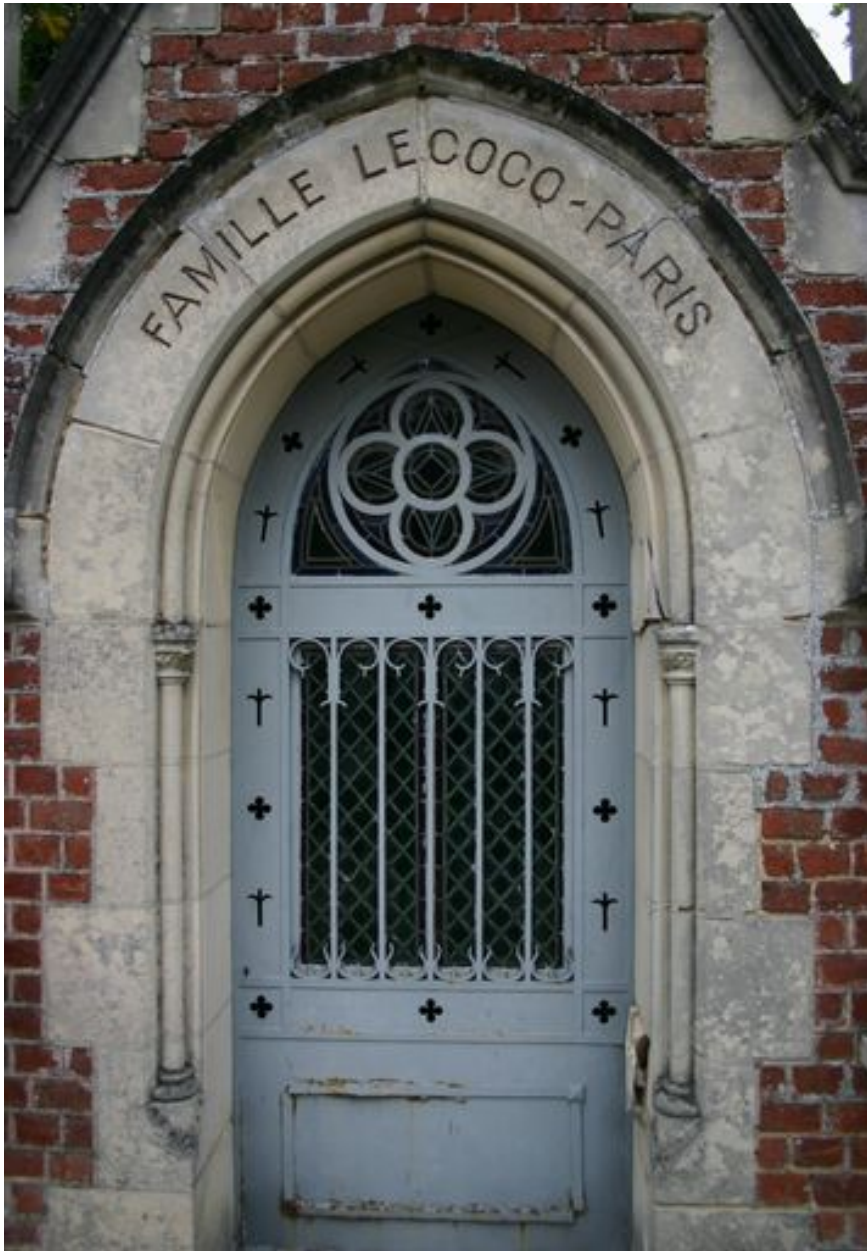
Détail de la porte en arc brisé, appareillée de pierre de taille.
