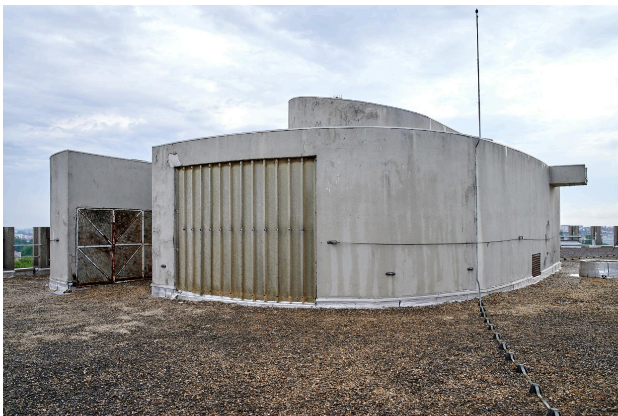
Toit-terrasse de la tour et local technique.
