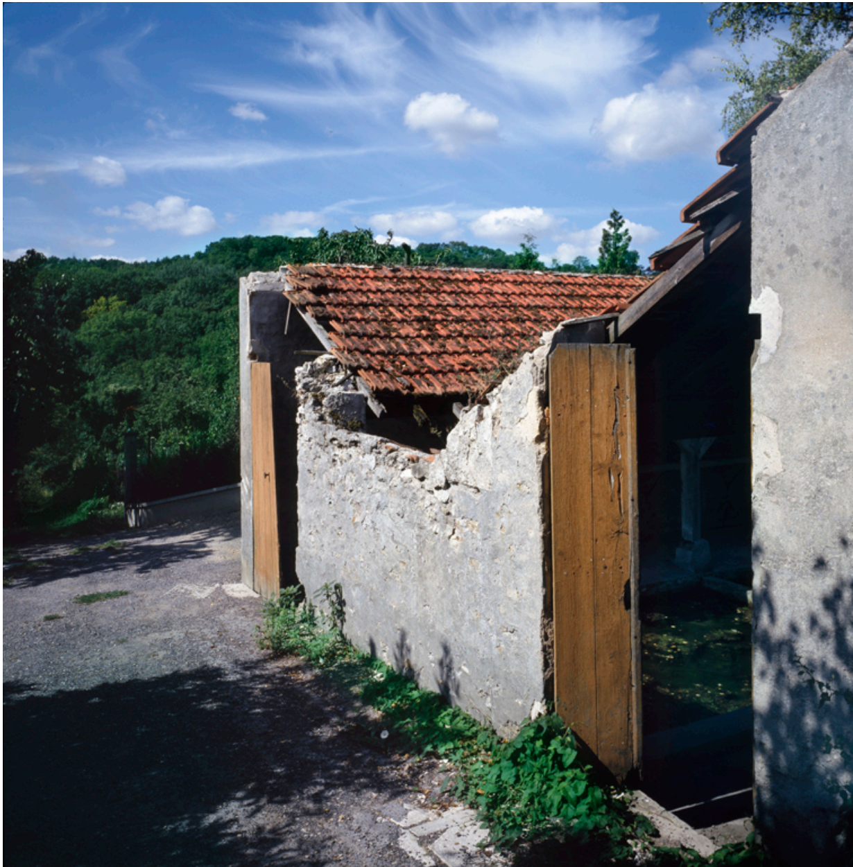
Lavoir : vue depuis la rue.
