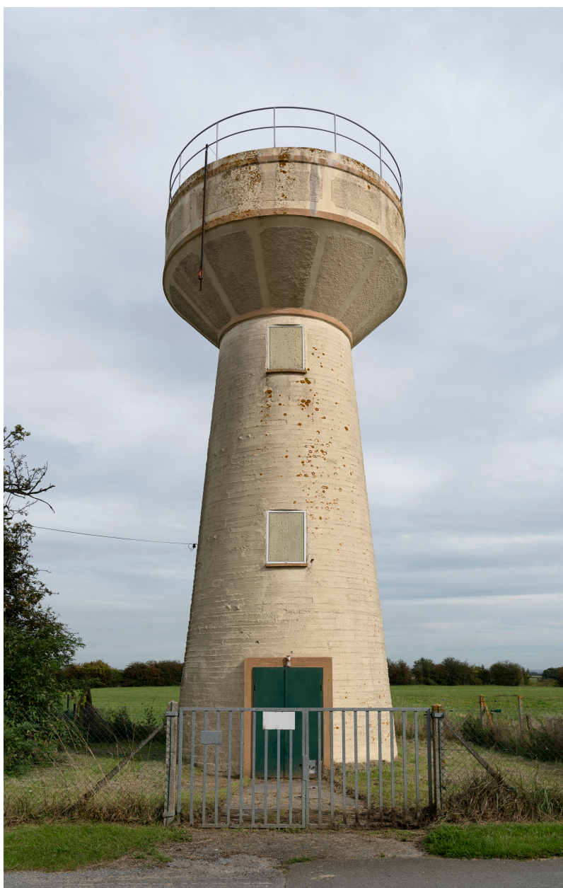
Château d'eau, troisième quart du 20e siècle.
