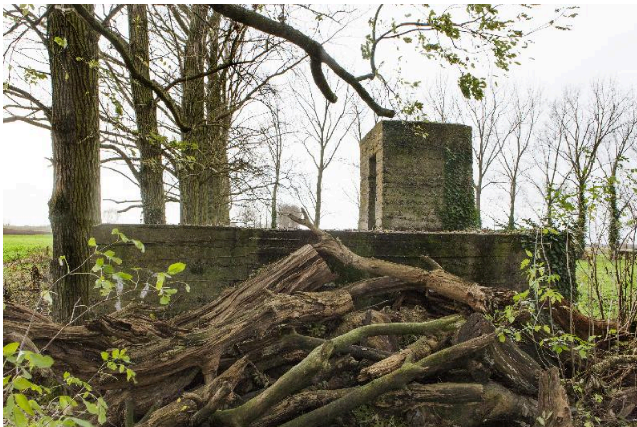
Vue latérale vers le sud-ouest
