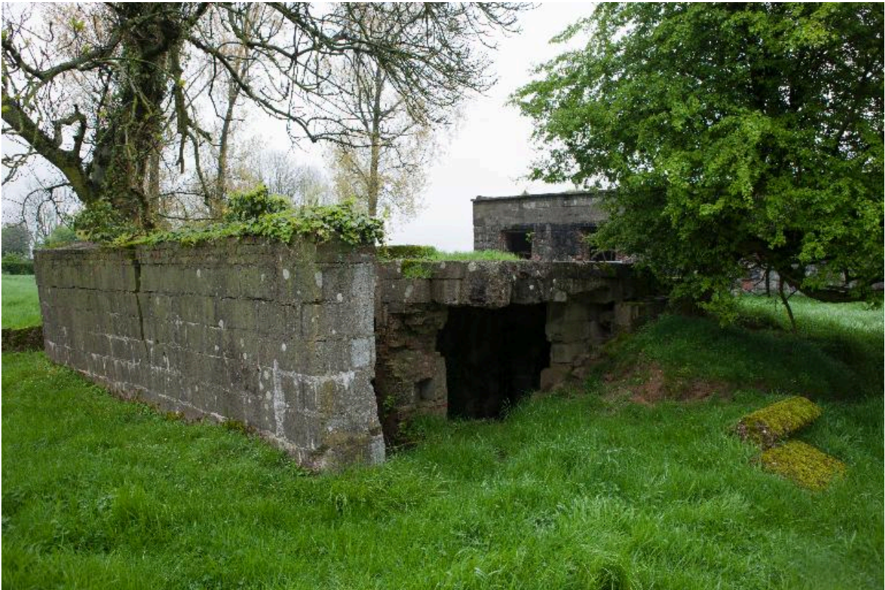
Bâtiment de stockage des réactifs chimiques. Angle sud-est.
