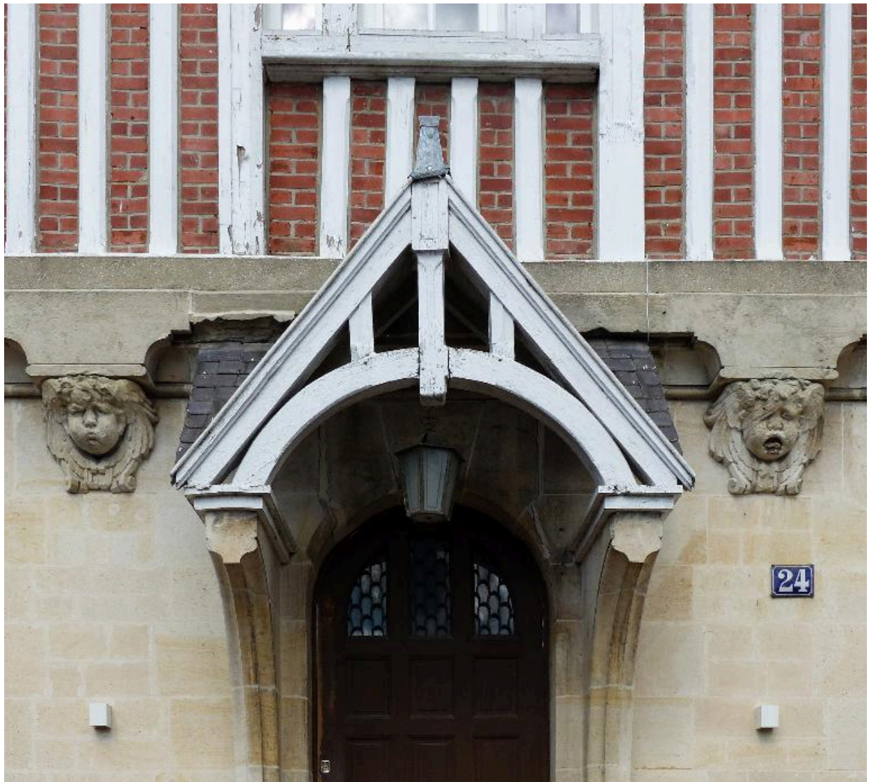
Vue de détail sur le porche.
