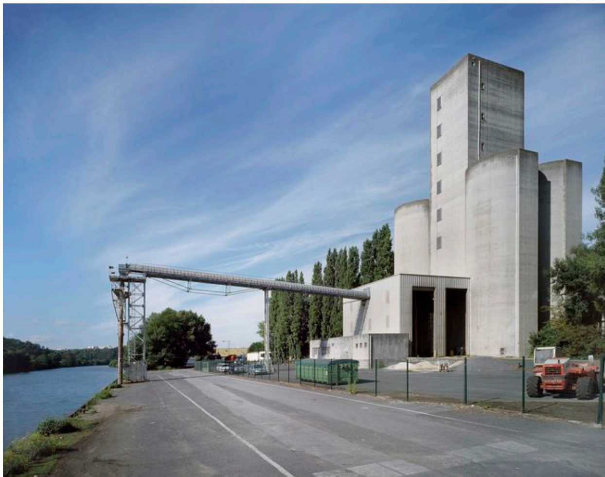
Vue générale du silo de Nogent-sur-Oise
