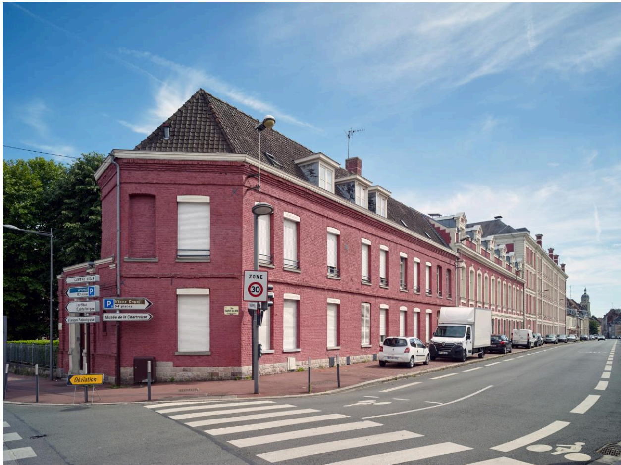
Vue de l'extrémité nord de la façade sur la rue Saint-Albin (bâtiment construit vers 1900).
