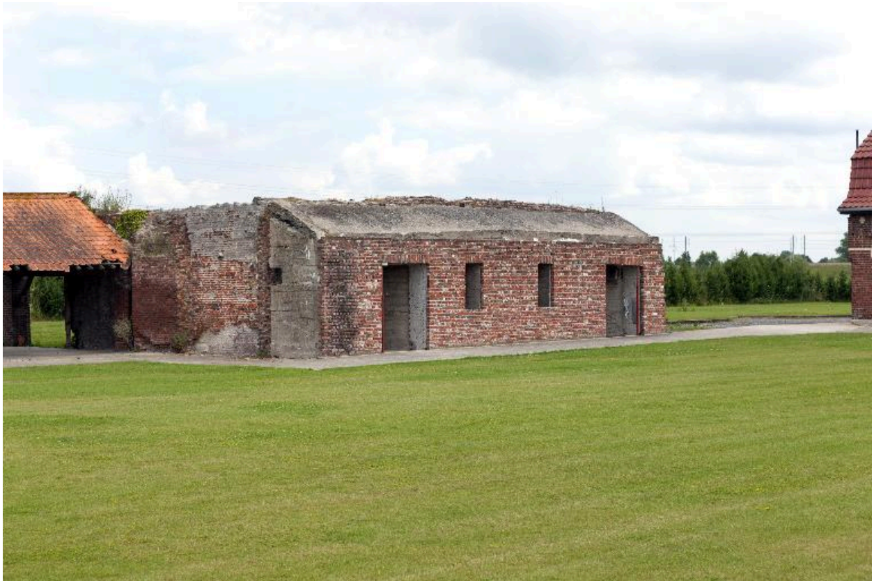
La casemate dans d'anciennes dépendances de la ferme, vers le nord
