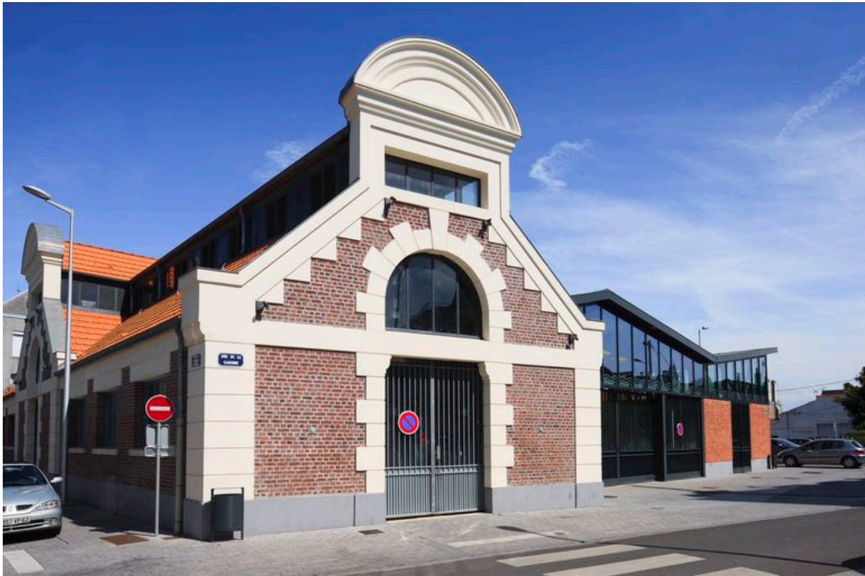
Vue générale de l'entrée ouest.
