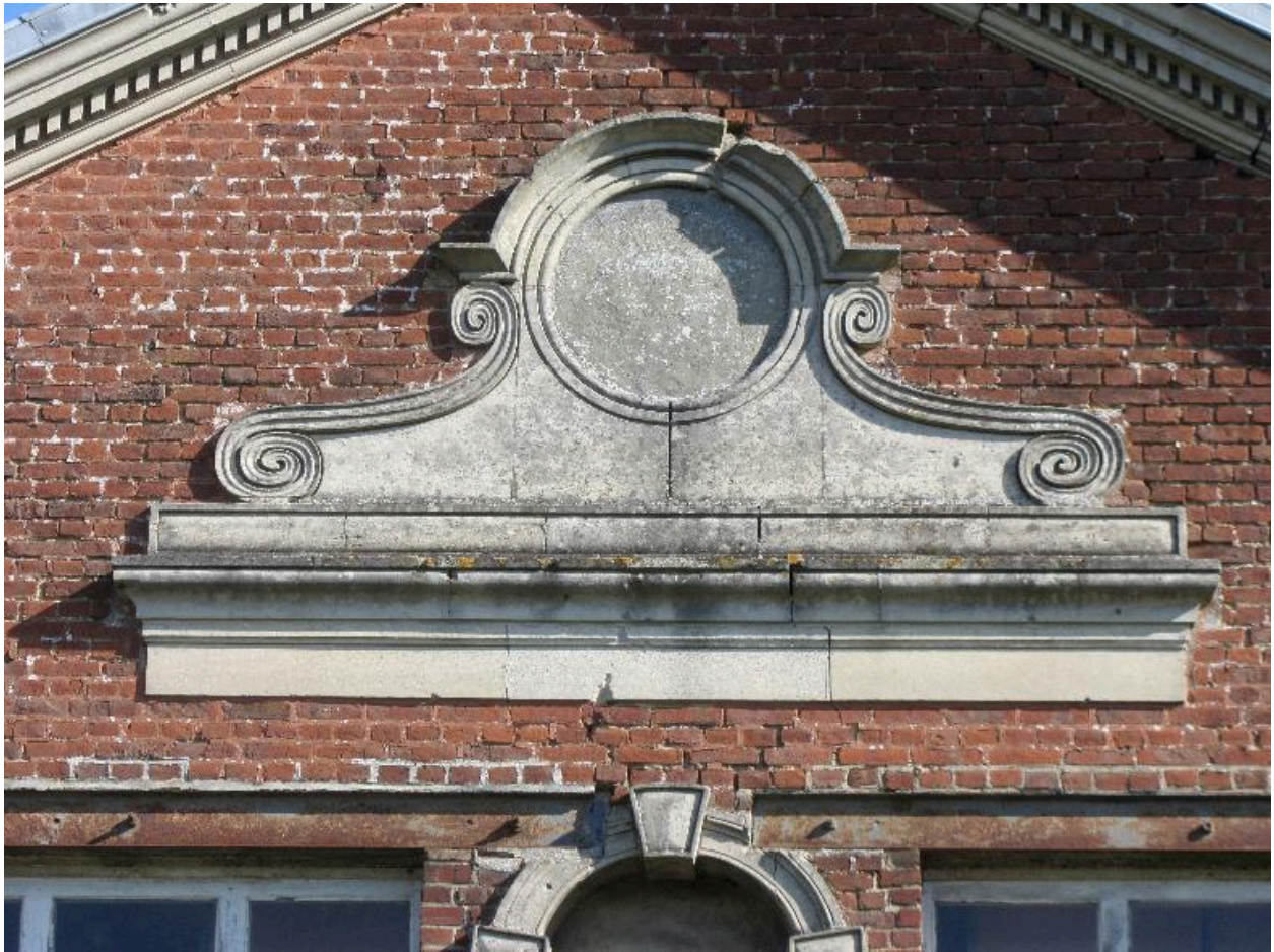
Détail du sommet du fronton de l'atelier de pliage.
