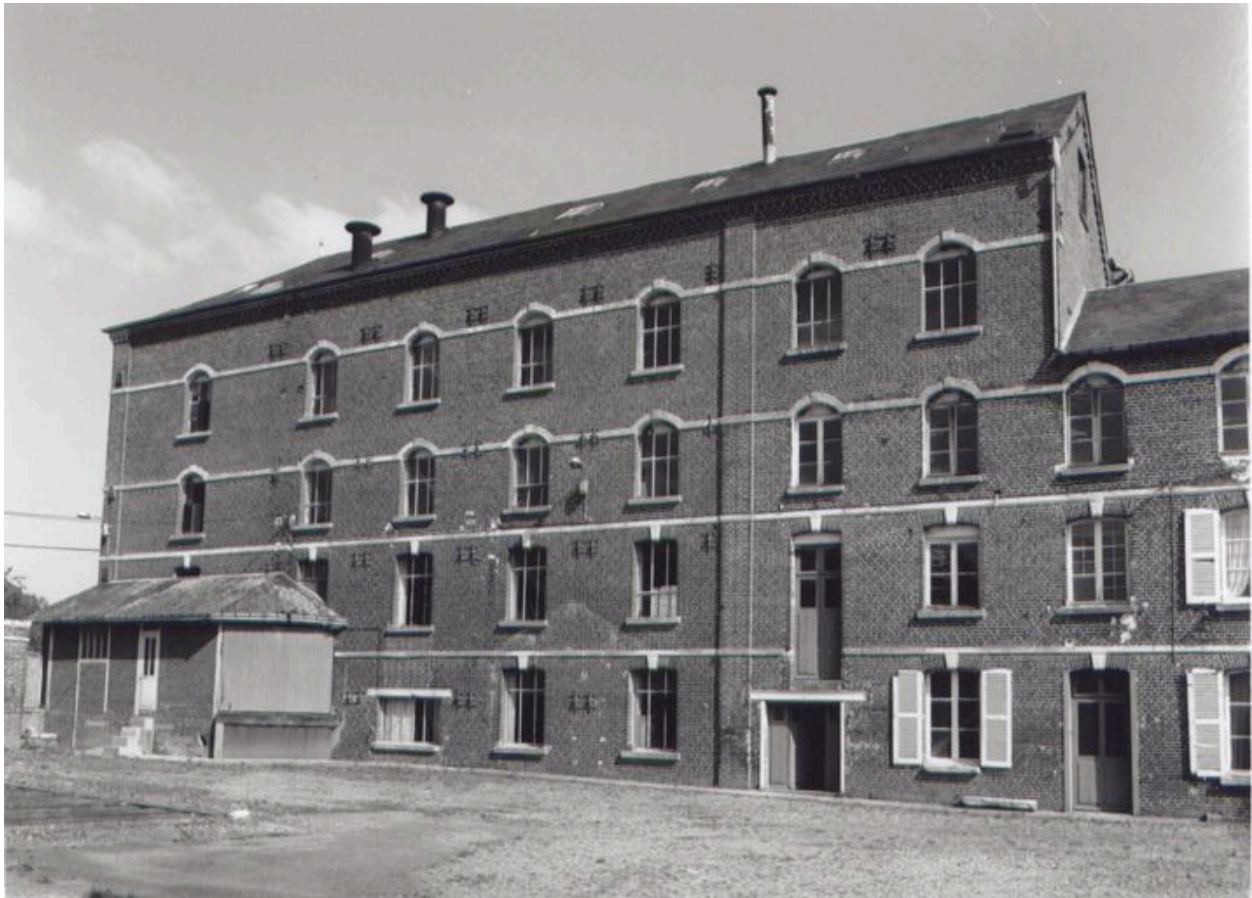
Vue d'ensemble du bâtiment de minoterie, façade sur cour.
