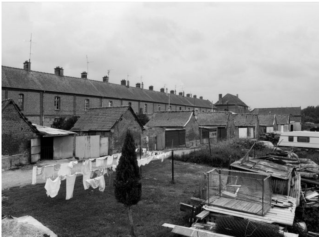
Logements d'ouvriers (rue des Moulins-Bleus), en 1991 : élévation postérieure.
