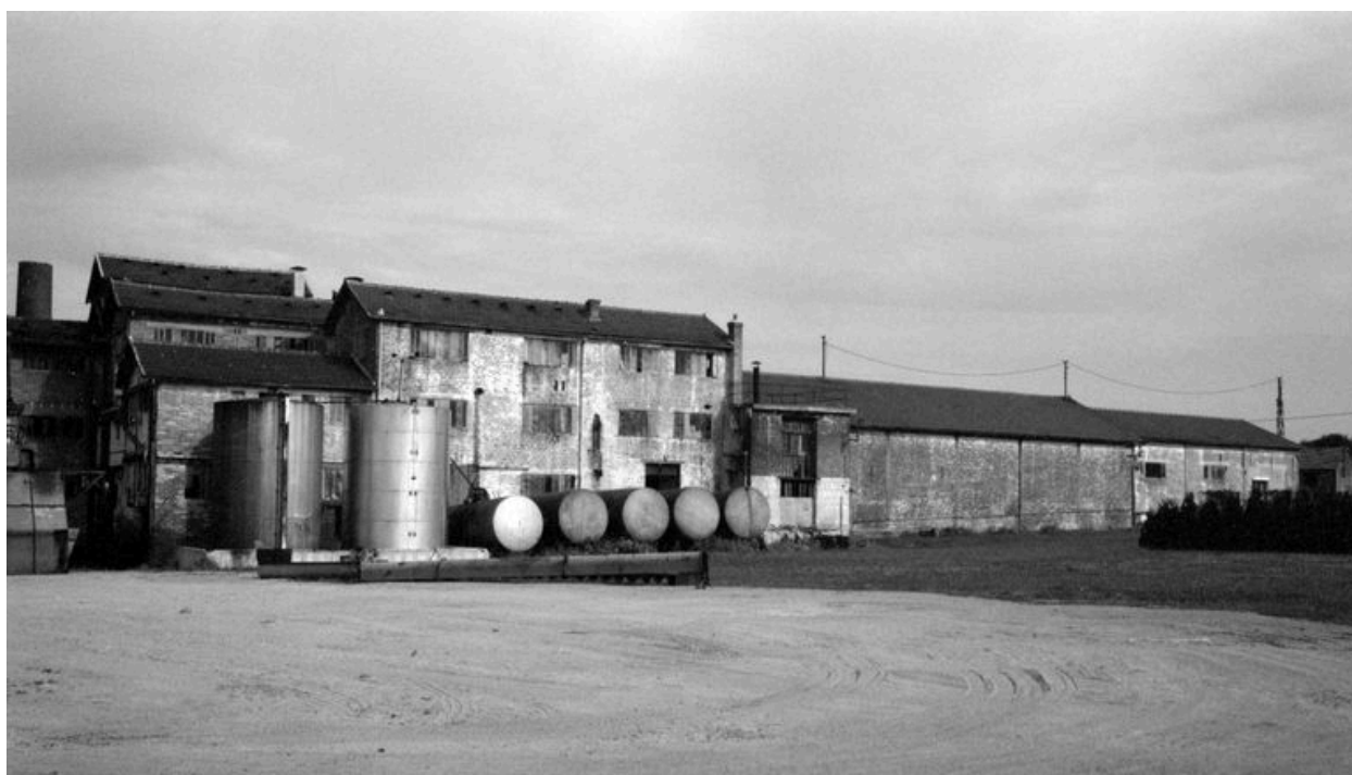
Vue générale : flanc ouest.
