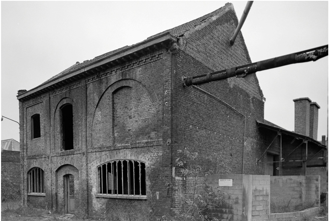
Remise, vue extérieure.
