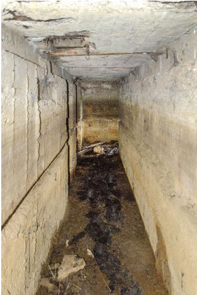
Vue en enfilade du couloir C1, vers l'est
