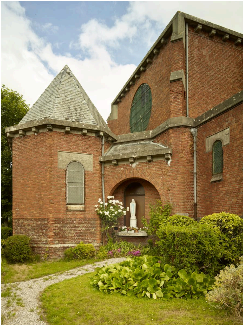
Vue extérieure de la chapelle des fonts baptismaux depuis le nord-ouest et de la chapelle de la Vierge attenante.
