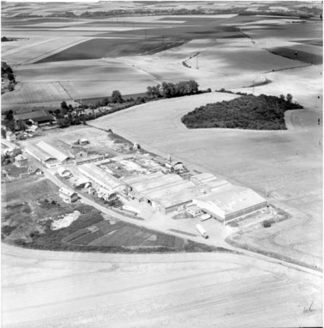
Vue aérienne de l'usine, flanc sud ouest.
