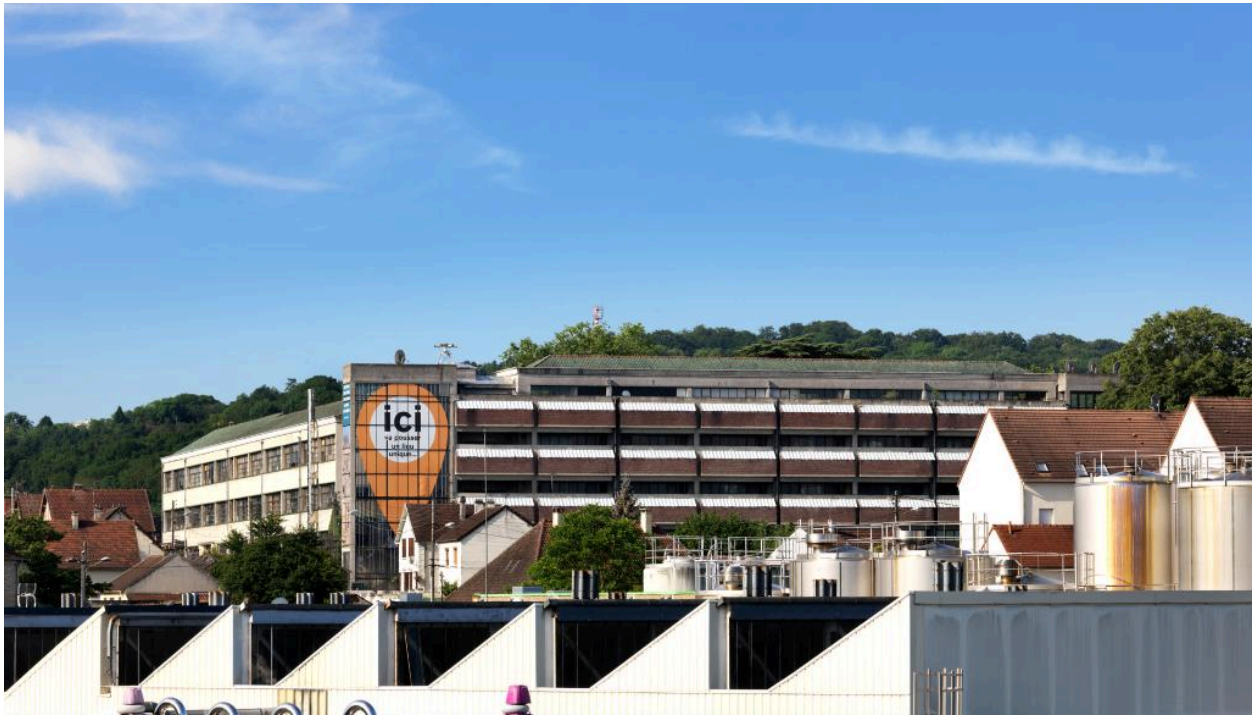
Vue d'ensemble nord depuis le pont de la ligne de chemin de fer.
